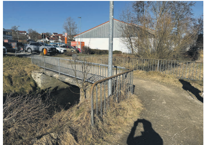
Die Brücke beim „Müller-Markt“ wird durch eine Edelstahlkonstruktion ersetzt.
