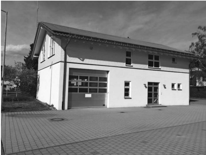
Das ausgeräumte Feuerwehrhaus im Rottumhang.
