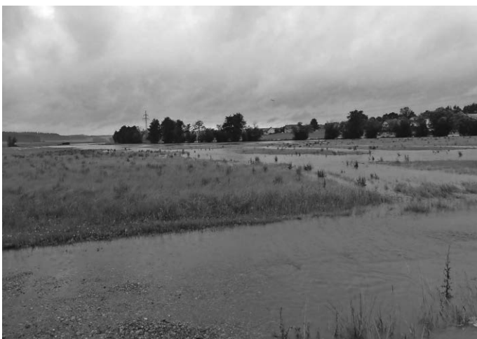
Überschwemmung in OX 02
