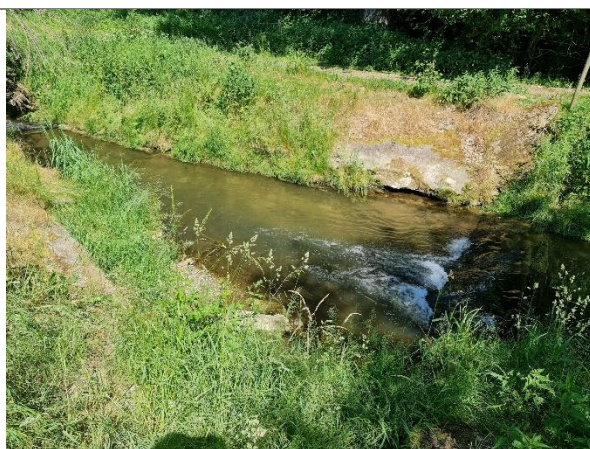
Abb. 15: Reste Wehranlage WKA Sägemühle
