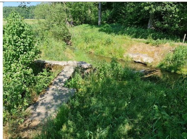
Abb. 14: Reste Ausleitungsbauwerk WKA Sägemühle
