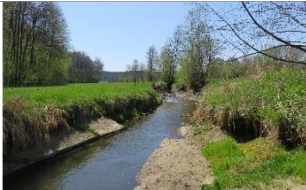
Uferverbau oberhalb alter Wehranlage in der Dürnach
