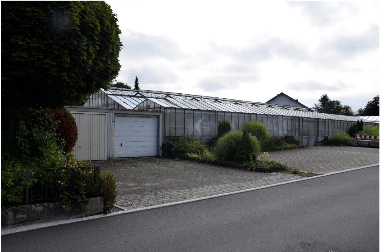
Abbildung 6: Ansicht der zum Abriss vorgesehenen Gewächshäuser.
